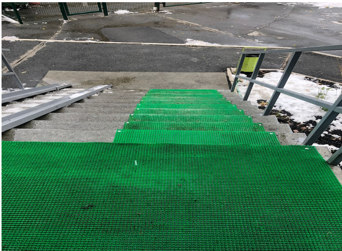
Монтаж противоскользящего покрытия
